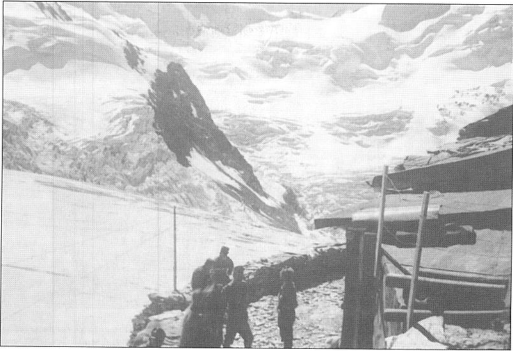
Foto 5 e 6: le baracche austriache site sulla spalla meridionale del Palon de la Mare ("baracche brnsade") nel 1918 (sopra; da G. Langhes: "La guerra fra rocce e ghiacci", 1991) e ai giorni nostri (sotto; G. Cola, 23 agosto 1998)
