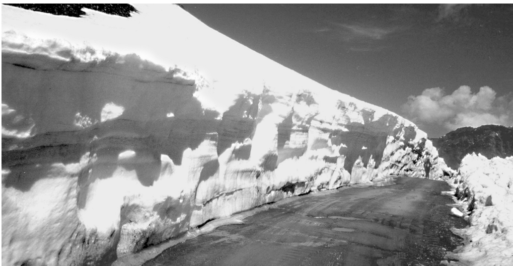
Foto 1: la strada del Passo delle Platigliole (2960 m, nei pressi del Passo dello Stelvio) agli inizi della primavera alla media quota alpina. Il muro di neve fresata, alto anche 8 m, attesta dell'enorme accumulo da vento qui depositosi nel corso della grande nevicata del mese di novembre 2002. (A. Galluccio, 4 giugno 2003).
